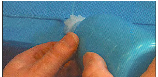
Solüsyon uygulaması Sealing the weld seam
